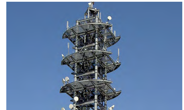
災害時に人口密集エリアの通信を確保する大ゾーン基地局
