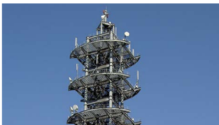
災害時に人口密集エリアの通信を確保する大ゾーン基地局
