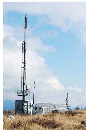
燃料電池を導入した野村大野ヶ原グリーン基地局(愛媛県)
