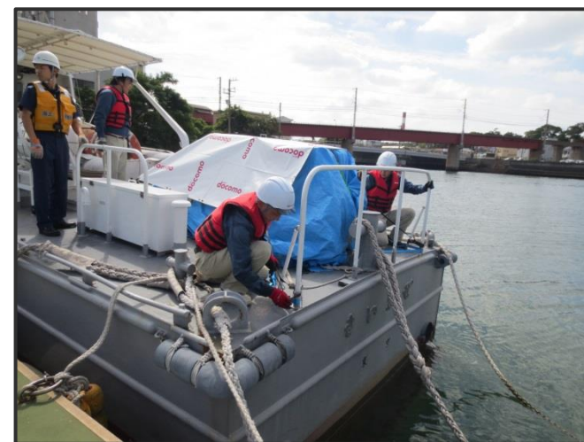
通信機材を甲板へ固定し、安定性を確認。
