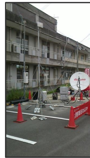
通信機材設営 （白浜町役場）
