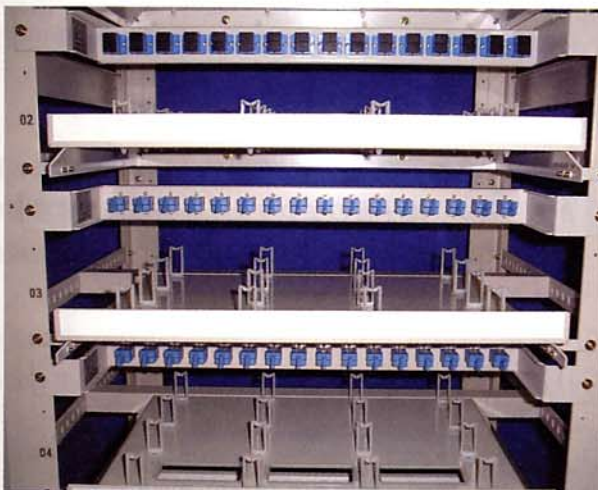
写真2 MS2000号A/B/C光コネクタパネル（上からA, B, C）
