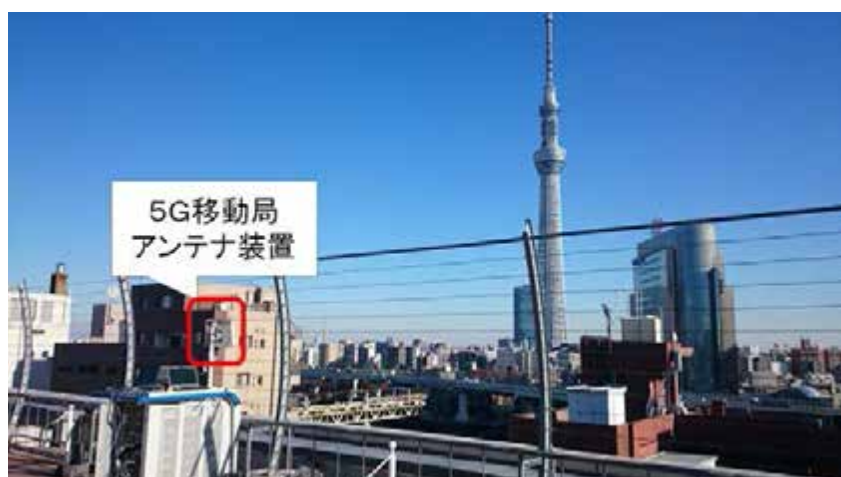
5G移動局装置(東武鉄道浅草駅ビル屋上)
