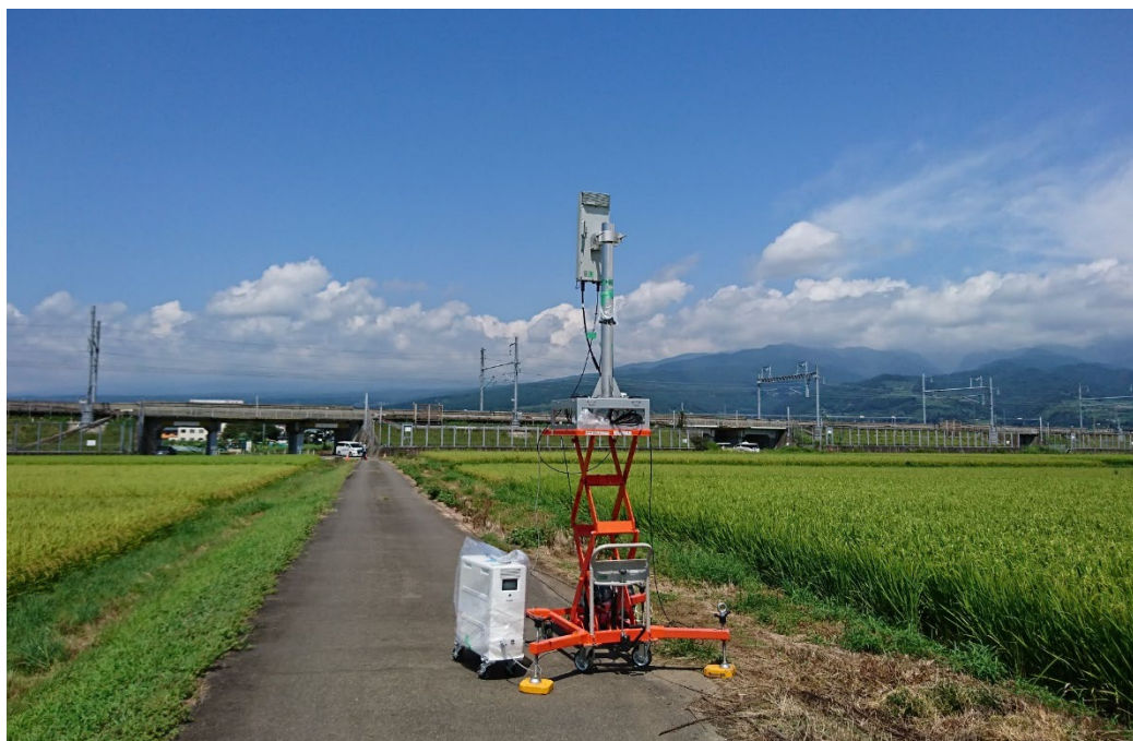
図2 実験用5G基地局を仮設置した東海道新幹線沿線の実験エリア
