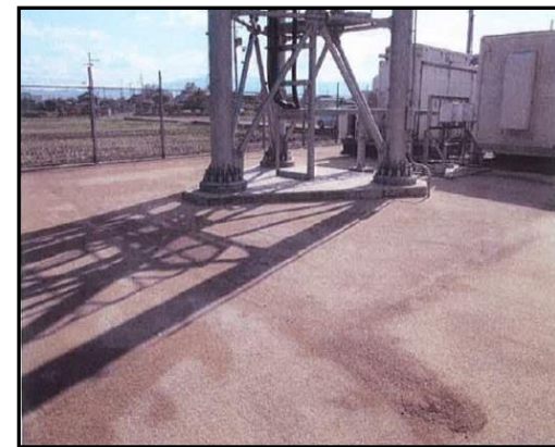
◎ 土舗装 温度低下、景観改善、防草
